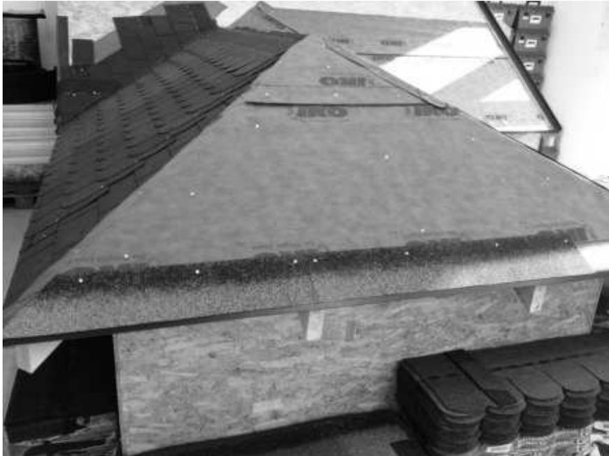
Erste Schindelreihe und Vorgehensweise bei der Verlegung weiterer Reihen:
